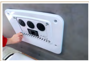
6. Установка внешней панели
