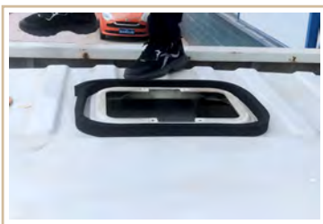
2. Фиксация губчатого уплотнителя
